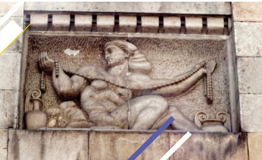
Na slici: Detalj sa fasade na zgradi Centralne banke.
